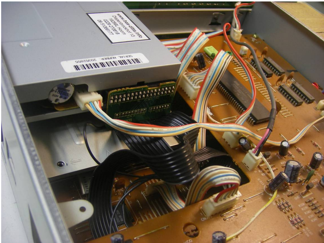
De bekabeling is aangesloten
